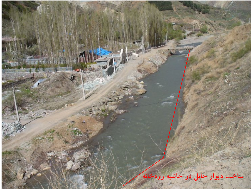
ساختگاه تقریبی دیوار حائل به منظور جلوگیری از تخریب توسط رودخانه. (دید به سوی شمال)
