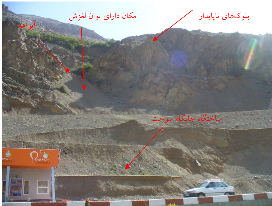
ساختمانگاه جایگاه سوخت و مخاطرات زمین‌شناسی پیرامون آن. (دید به سوی خاور، شمال خاوری)
