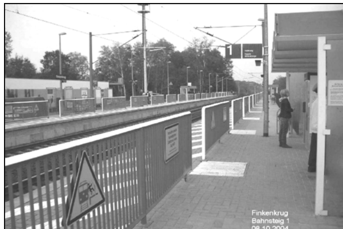
شکل ۳-۸: حفاظ سکو در راه آهن پرسرعت آلمان
