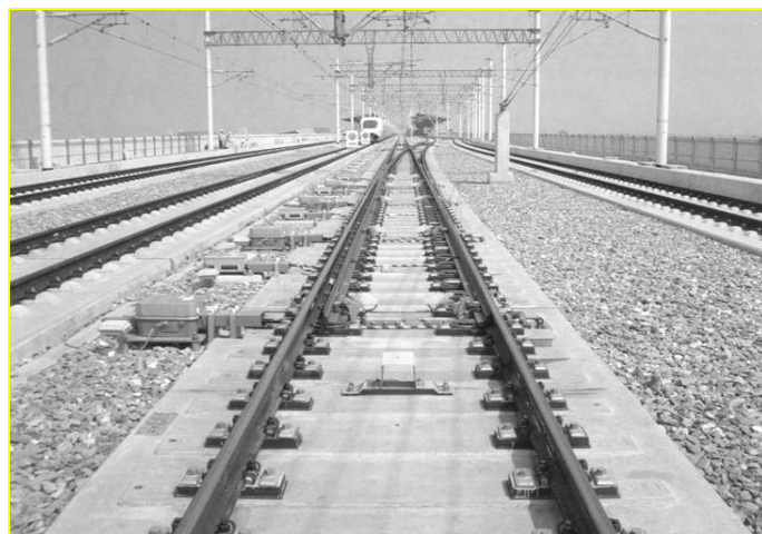
شکل ۳-۲: نمونه دوراهاه در راه آهن پرسرعت تایوان
