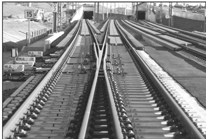
شکل ۱-۳: قلب سوزن متحرک در خطوط راه آهن پرسرعت
