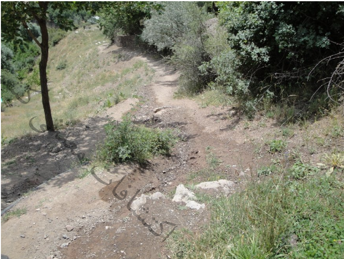
شکل ۸: تزریق آب ناشی از آبیاری باغ‌ها و دفع فاضلاب به ترک‌های ایجاد شده در دامنه سبب سرعت بخشیدن به حرکت دامنه می‌شود. (دید به سوی جنوب خاوری).
