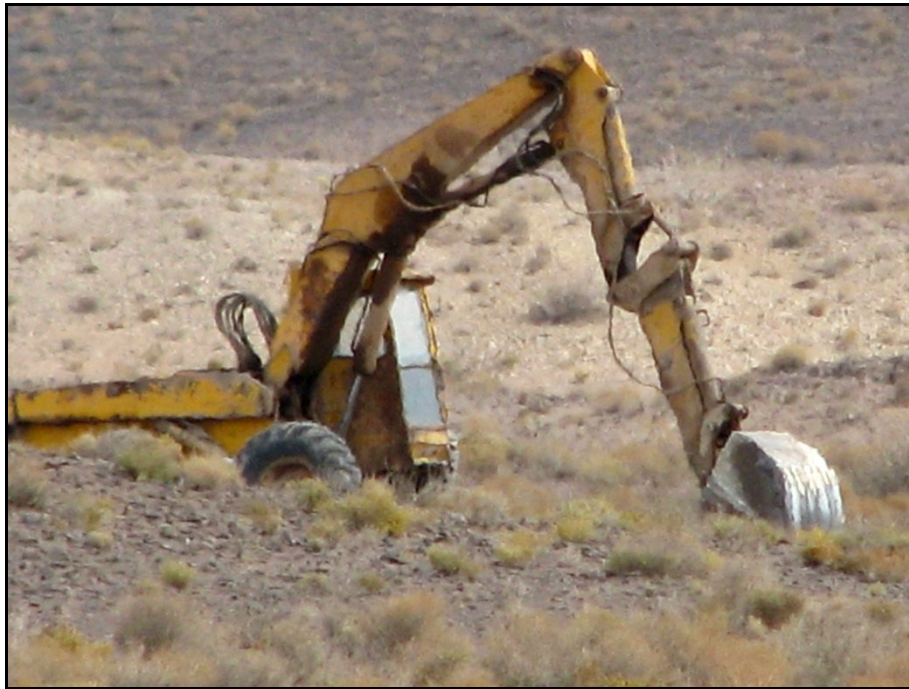
شکل (۳-۶۴): معدن بنتونیت فعال در حال استخراج در مسیر پیمایش شماره ۱۰ (در حال ترانشه زدن برای بنتونیت).
