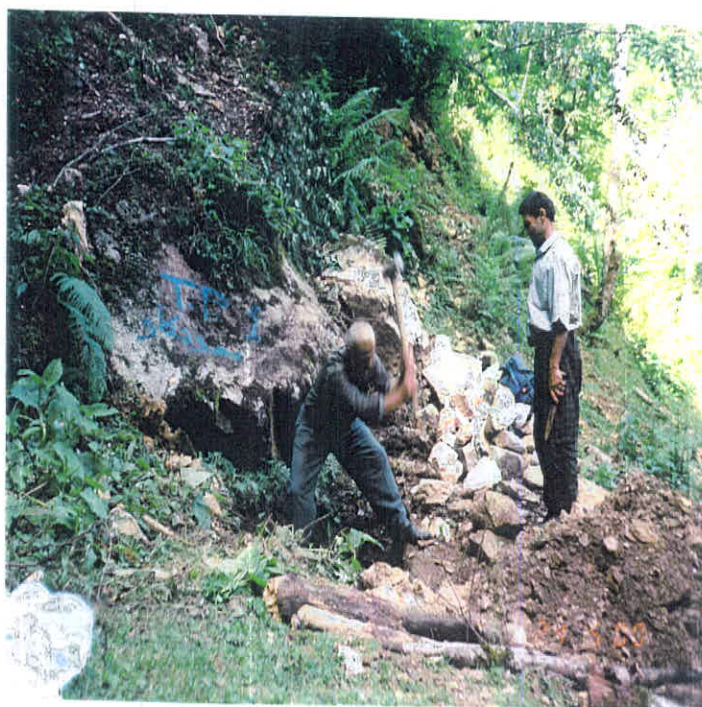
عکس شماره (۵-۵)- عملیات حفاری در چاهک Tp.1 و موقعیت آن در منطقه
