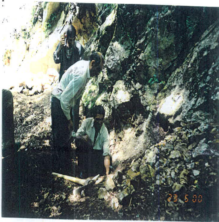
عکس شماره (۱۰-۵) - نمایی از عملیات حفاری در چاهک Tp.1 منطقه مالمون
