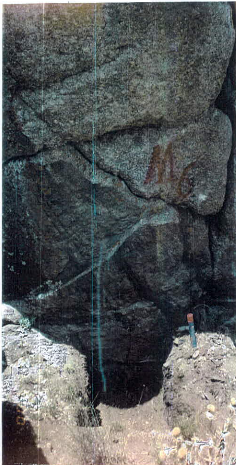
عکس شماره (۴-۶) - نمایی از ترانشه M6 و سنگهای اطراف آن
