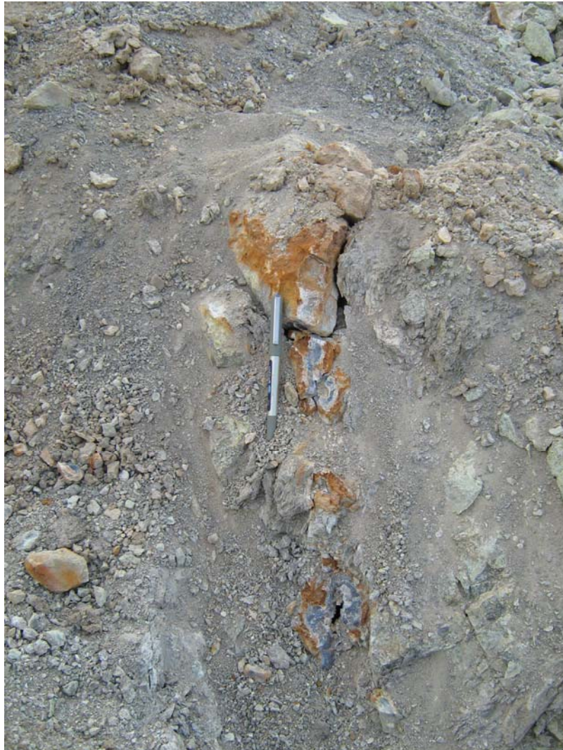
شکل ۲-۱-۸): تصویری از عملیات حفاری در منطقه مزار گاهی
