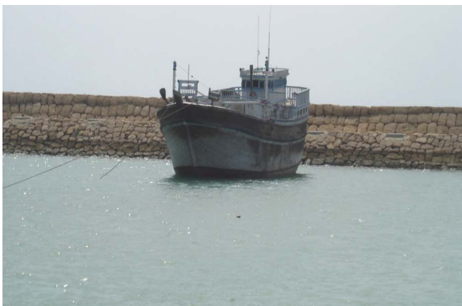
شکل ۱-۱۱ استفاده از لوماشل در ساخت موج شکن- بندر صیادی پزم
