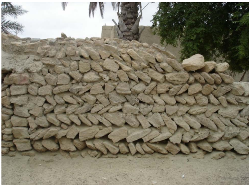
شکل ۱-۱۲ استفاده از لوماشل بعنوان مصالح ساختمانی (مالون) - روستای طیس
