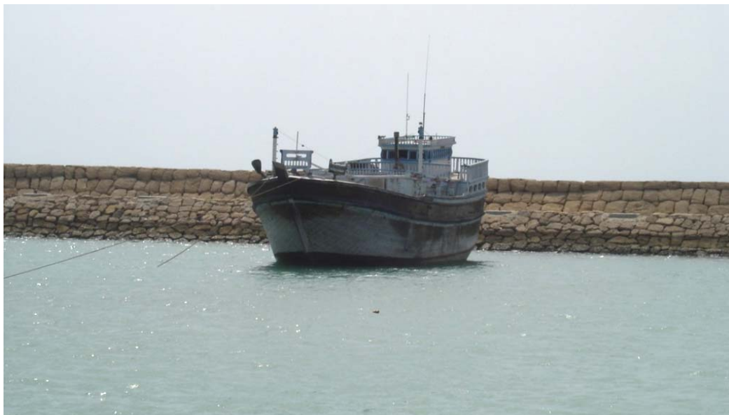
شکل ۳-۱۲۷ نمای از موج شکن بندر جدید کلات
