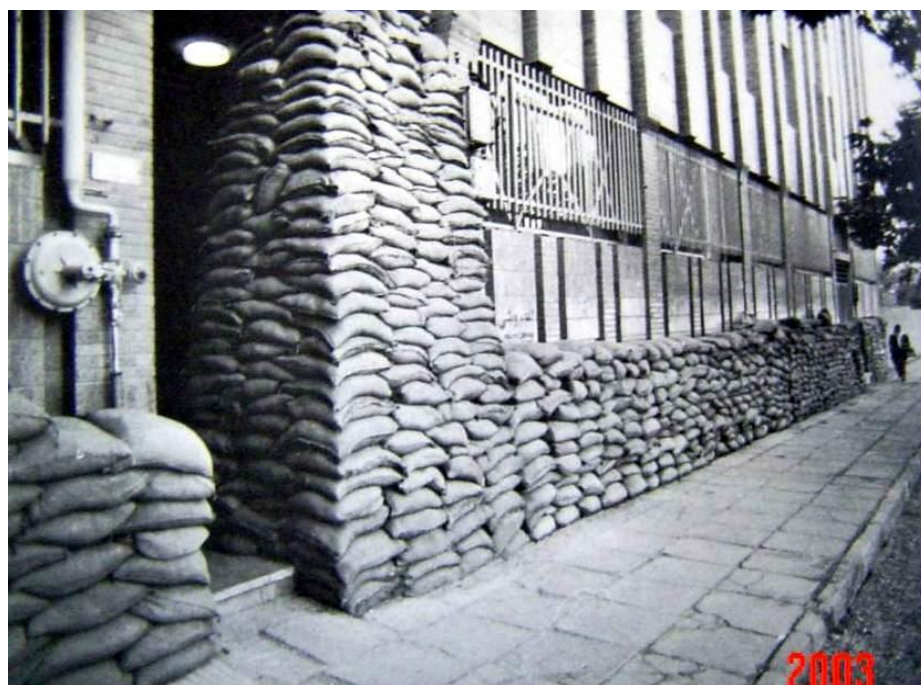
شکل ۲-۶۰ استفاده از کیسه‌های شنی بر روی دیوار خارجی یک ساختمان در شهر تهران
