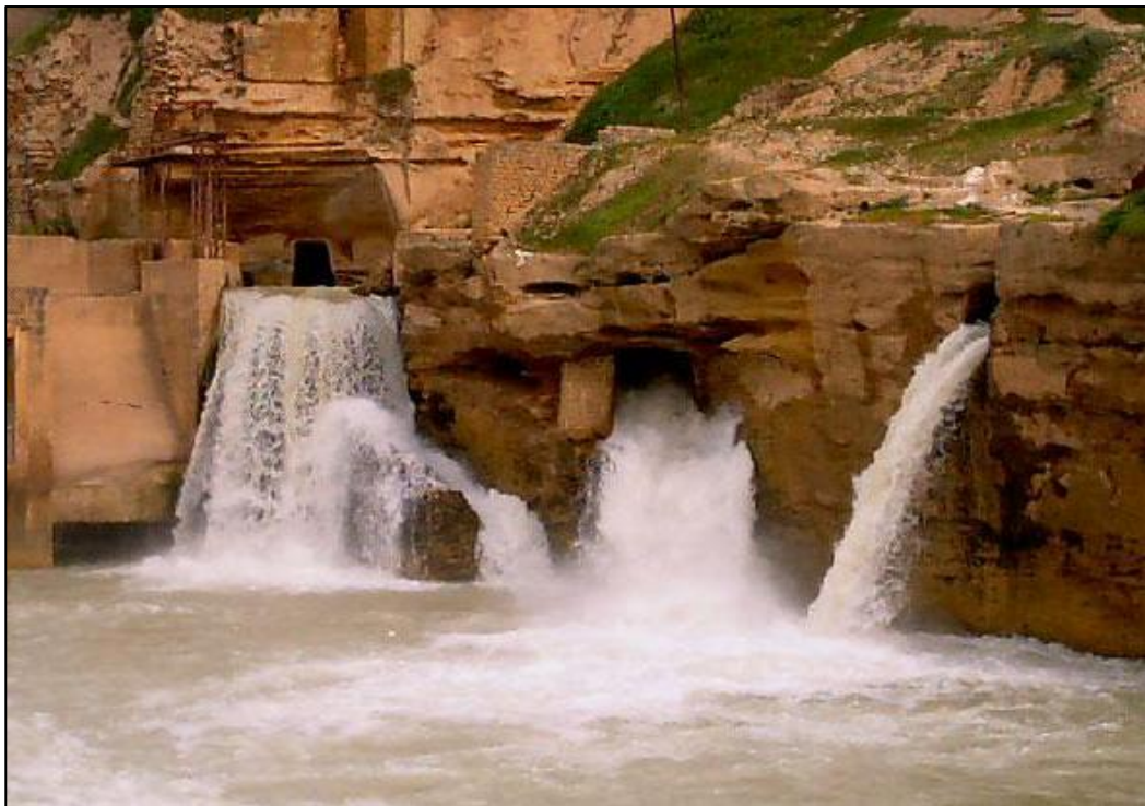
شکل ۶-۱۶ تصویری از سازه‌های آبی شوشتر
