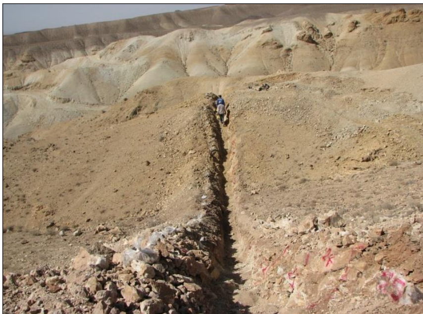
شکل ۳-۱۳ نمایی از ترانشه های حفر شده در منطقه
