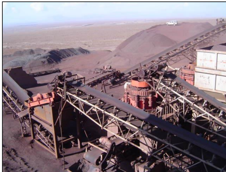
شکل ۴-۴ نمایی از نوار نقاله‌ها و سایر دستگاه‌های بخش خردایش کارخانه سنگ آهن سنگان
