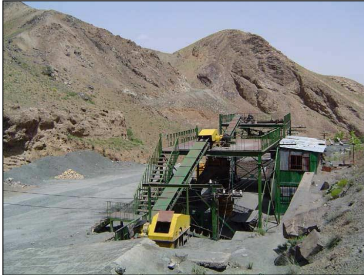
شکل ۴-۵ نمای کلی از کارخانه تغلیظ کرومیت گفتم
