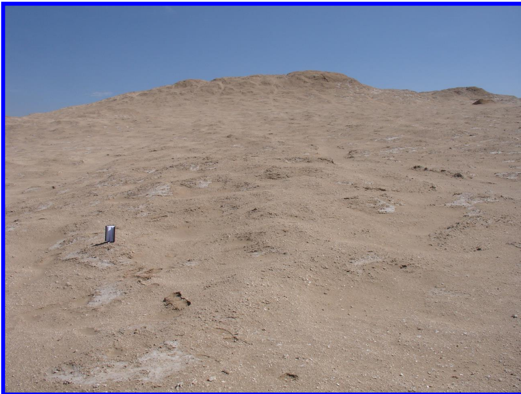
تصویر شماره 79: نمایی از بام گنبد نمکی عصر آباد که سنگ پوشش آن بر اثر باد فرسایش پیدا کرده و به صورت لخت درآمده (نگاه به سمت جنوب)
