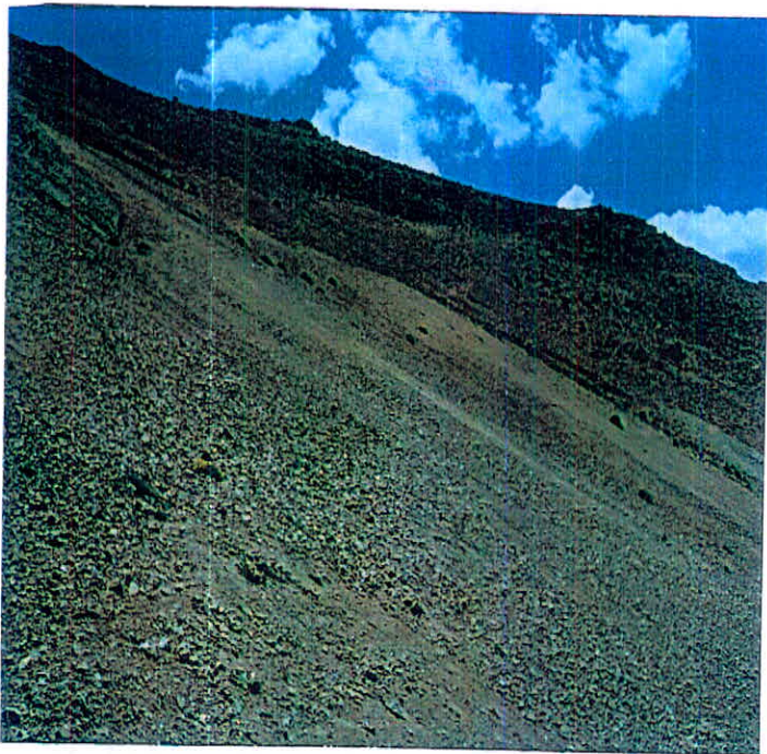
عکس شماره (۳-۴) - حالت ریزشی حفریات معدن سرب یورت بابا. دید به سمت جنوب غرب
