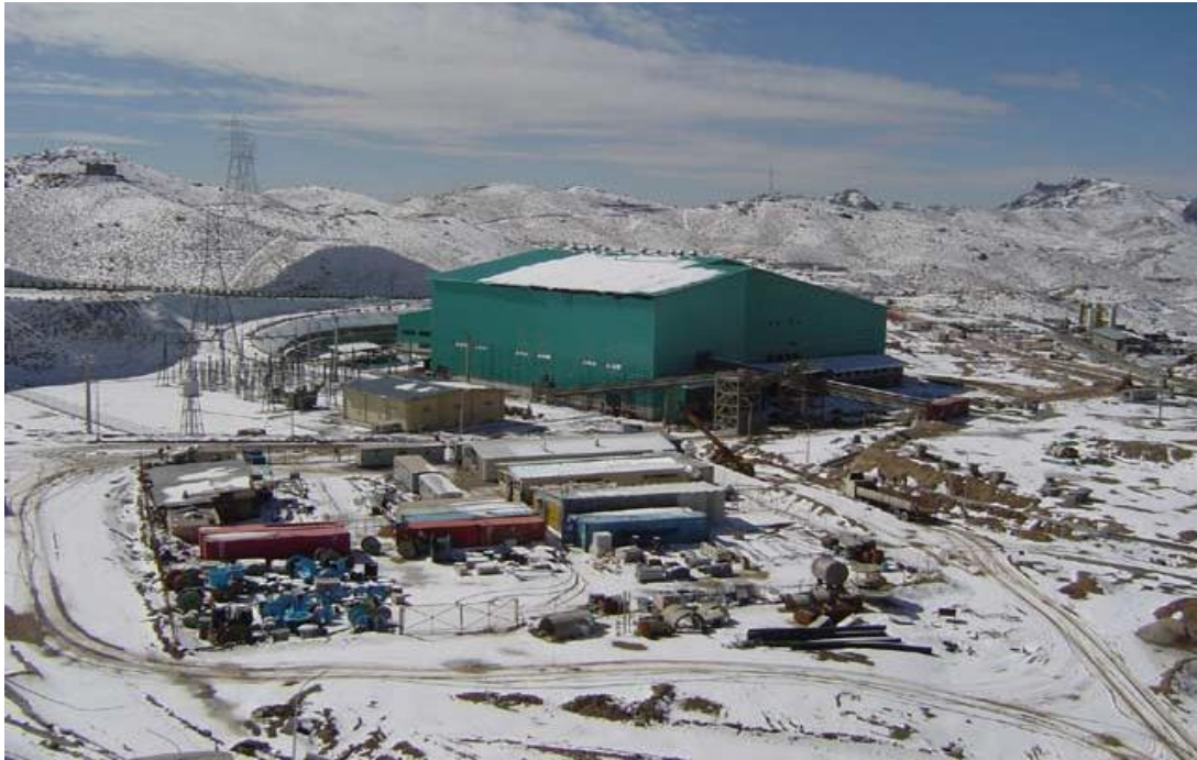
شکل ۲-۳۴ نمای کلی از کارخانه تغلیظ مس میدوک
