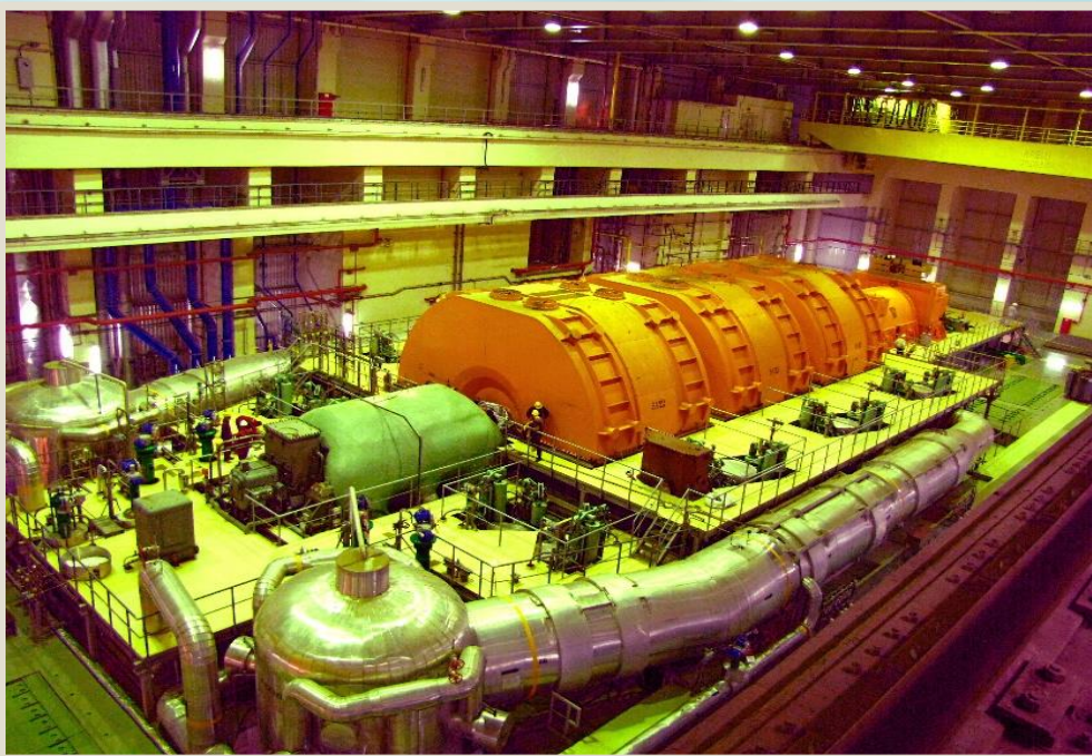
ساختمان توربین نیروگاه هسته‌ای بوشهر
