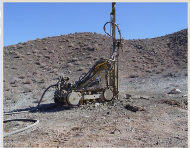
عملیات حفر گمانه اکتشافی
