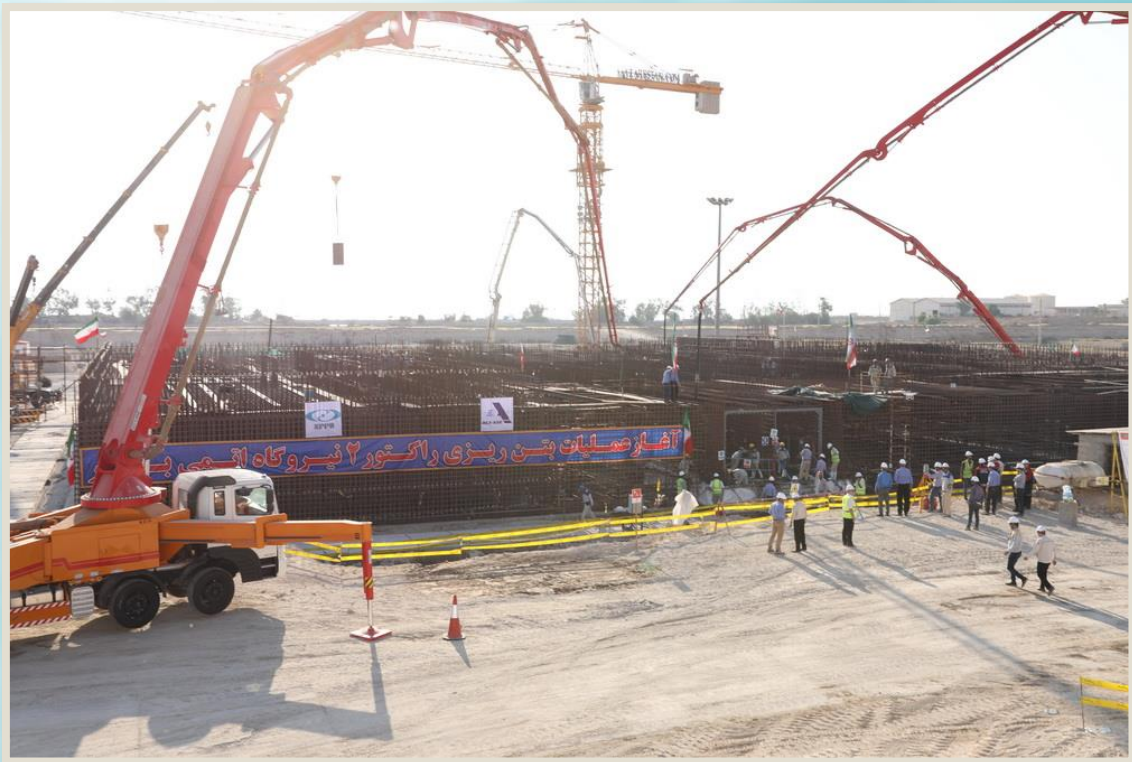
آغاز عملیات بتن‌ریزی واحد ۲ نیروگاه اتمی بوشهر
