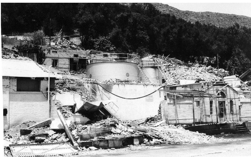
شکل ۳-۲۳ عدم آسیب دیدگی مخازن ۵۰۰،۰۰۰ لیتری بنزین با وجود تخریب سازه‌های اطراف پمپ بنزین (عکس از مهندس نادرزاده)
