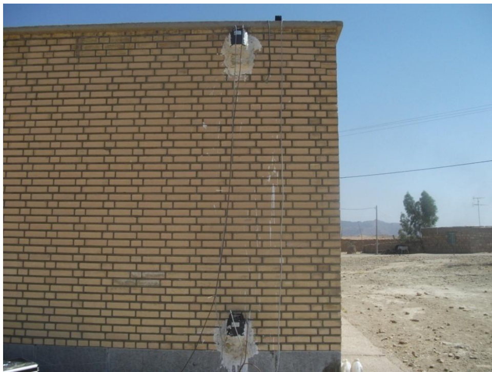
شکل ۴-۲۰ نصب سنسورهای جهت ثبت ارتعاشات سازه‌ای در اثر انفجار
