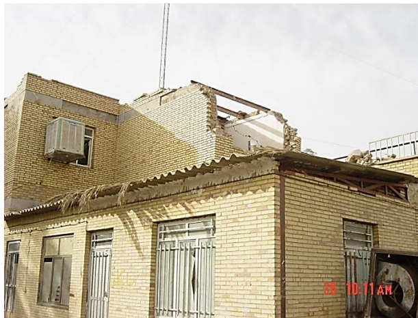
شکل ۳-۳۲ محل نصب ایستگاه شتابنگاری در فرمانداری بم
