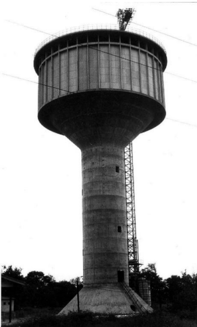
شکل ۱۹-۳ عبور گسیختگی از کف و دیوار خانه مسکونی در پاکده (راست). عدم فروریزش در منبع آب تازه احداث در شهر رشت (چپ)، هنگام وقوع زمین‌لرزه منبع خالی بود (عکس از مهندس نادرزاده).
