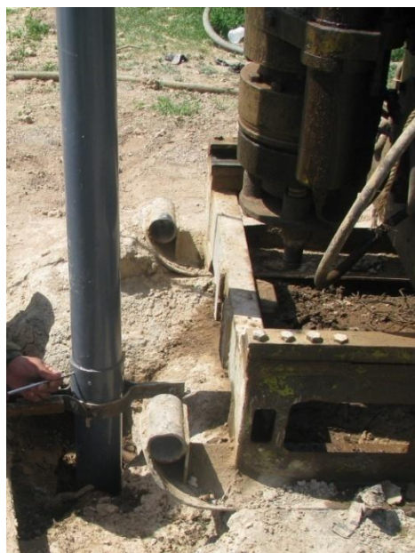
شکل ۱۴-۴ عملیات لوله‌گذاری در یکی از ایستگاه‌های شتابنگاری
