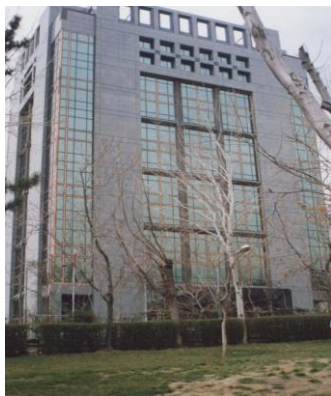
شکل ۴-۱۰ ساختمان مرکزی وزارت مسکن و شهرسازی و دستگاه‌های نصب شده در آن
