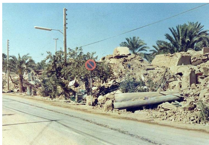
شکل ۳-۱۲ خرابی‌های ناشی از زمین‌لرزه طیس، شهریور ۱۳۵۷
