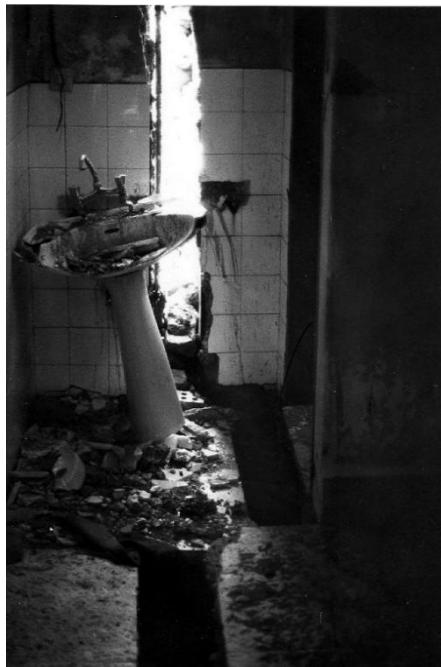
شکل ۱۹-۳ عبور گسیختگی از کف و دیوار خانه مسکونی در پاکده (راست). عدم فروریزش در منبع آب تازه احداث در شهر رشت (چپ)، هنگام وقوع زمین‌لرزه منبع خالی بود (عکس از مهندس نادرزاده).
