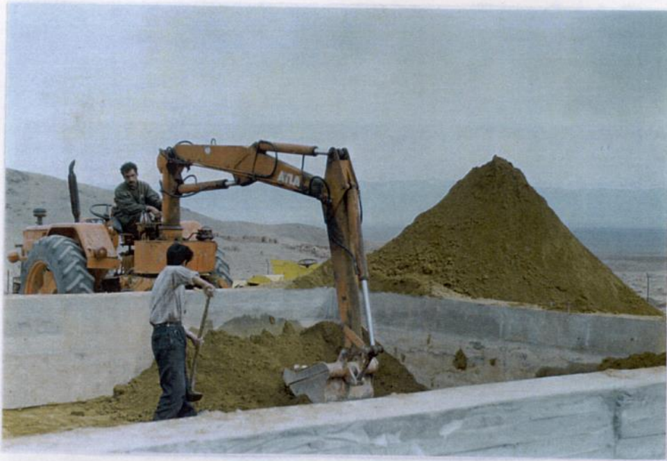
عکس ۹- نمایی از تخلیه حوضچه لیچ توسط بیل مکانیکی و کارگر
