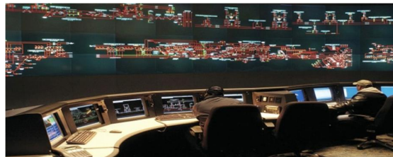
شکل ۶: پانل فرماندهی etc و کنترل
