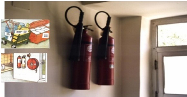
بازدید مستمر کلیه وسایل آتش نشانی ایستگاه و ساختمانها و انبارهای کالا و توشه
