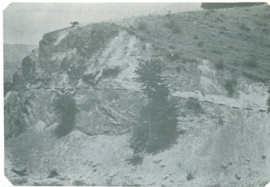
نگاره‌ی ۴۰۱۴ الف- سفره‌ی رورانده‌ی شمال تهران در شاه‌آباد. نگاه بسوی شمال (اردیبهشت ماه ۱۳۶۴). در این برش سازند انوسن کرج بر روی نهشته‌های آبرفتی کواترنر رانده شده است.
