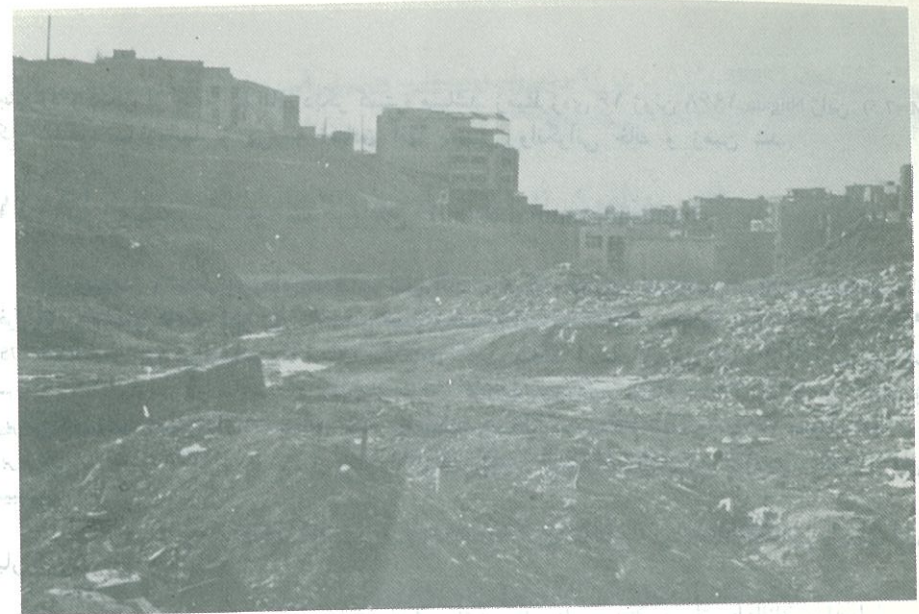
نگاره‌ی ۱۰۹- ساختمانهای مسکونی بر روی مسیل قدیمی رودخانه‌ی درکه در شمال یوسف‌آباد تهران که بوسیله‌ی خاک دستی پر شده است (نگاه بسوی شمال ۱۳۶۲ خورشیدی).
