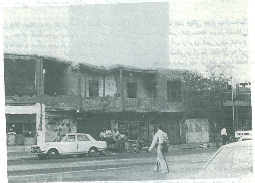
نگاره‌ی ۱۰۴ - سقف خم شده‌ی خانه‌ی دو طبقه با مصالح نامرغوب در نبش سرپل خیابان شیر و خورشید (نگاره از ع. صمدیان ۱۳۵۹ خورشیدی).
