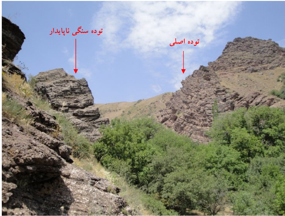
شکل ۹: جدایش بلوک‌های سنگی از توده اصلی بر اثر فعالیت‌های زمین‌ساختی و رخداد زلزله. (دید به سوی شمال).
