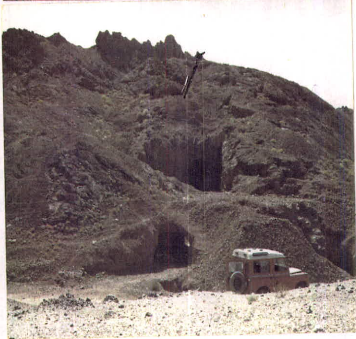
عکس شماره ۲ : تونل اصلی و ترانشه‌های سطح زمین کارگاه کندو شکن معدن خانچار رشم نگاه بطرف جنوب شرق
