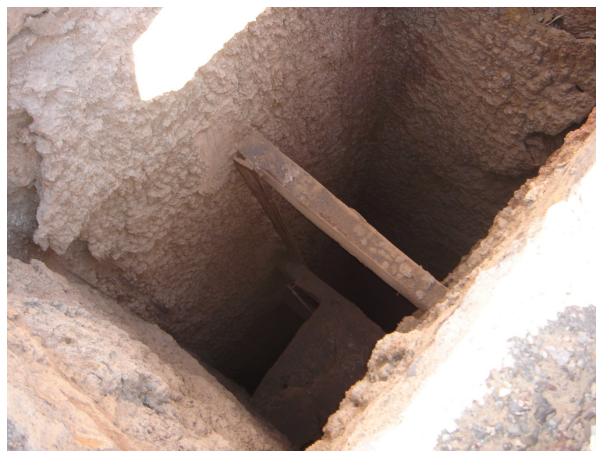
شکل ۱۷-۱-نمایی از دهانه چاه و دودکش تهویه تونل اکیپ آلمانی
