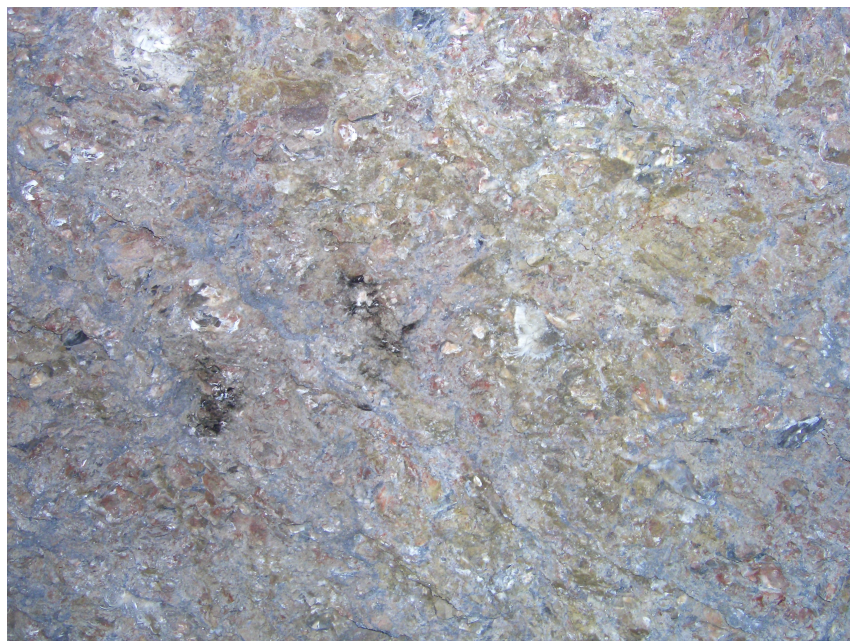
شکل ۳-۱۳- رگچه‌های درون زون شکستگی در دیواره تونل قدیمی چاه پلنگ
