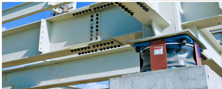
ب) جزئیات جداساز مورد استفاده و نحوه اجرای آن
