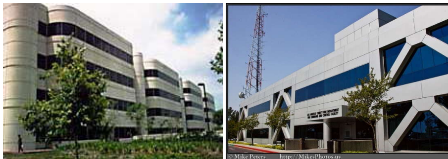
الف) ساختمان سازمان فرماندهی و کنترل آتش نشانی شهر لس آنجلس ب) مرکز قانون و عدالت اجتماعی فوت هیل ۳۷ واقع در شهر سان برناندینو
