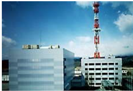
(ب) ساختمان مرکز پست غرب ژاپن
