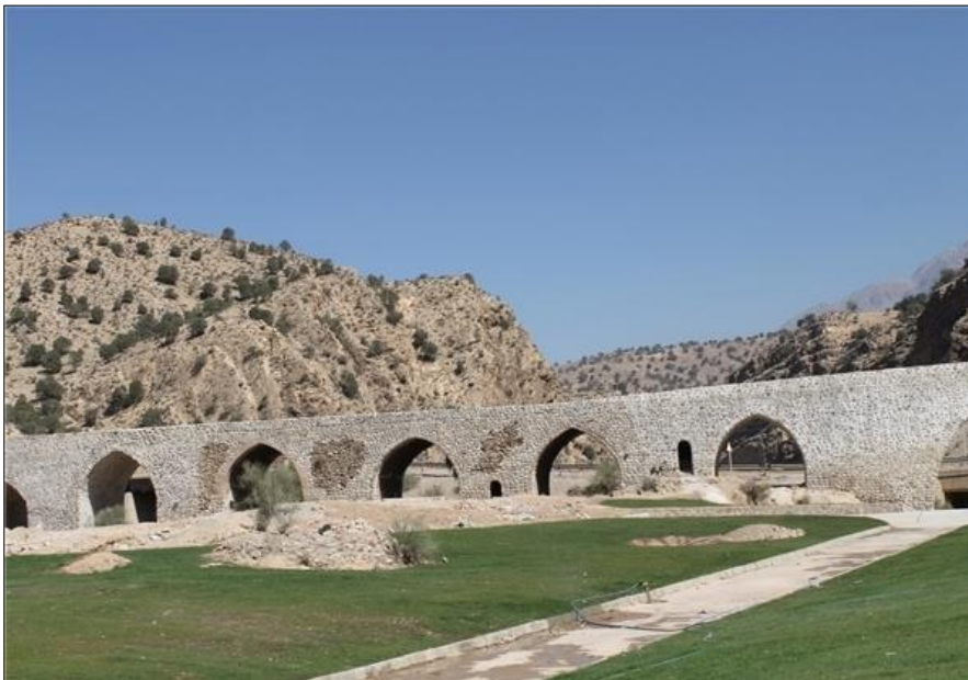
شکل ۴-۶- دورنمایی از پل پاتاوه
