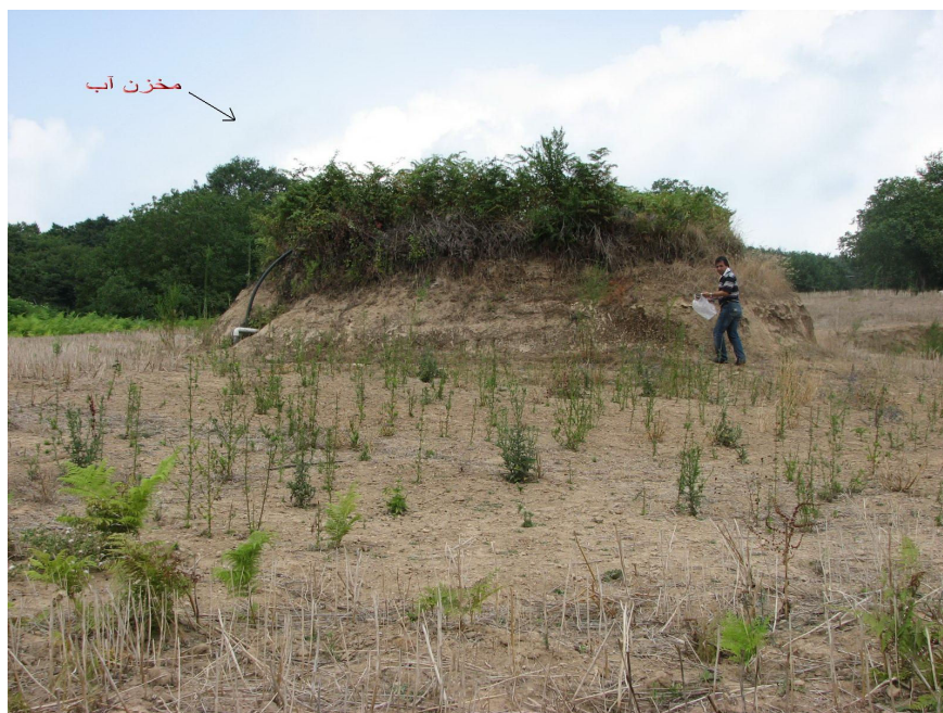
تصویر ۷- مخزن آب ساخته شده بر روی دیهیم (Crown) توده لغزشی اصلی
