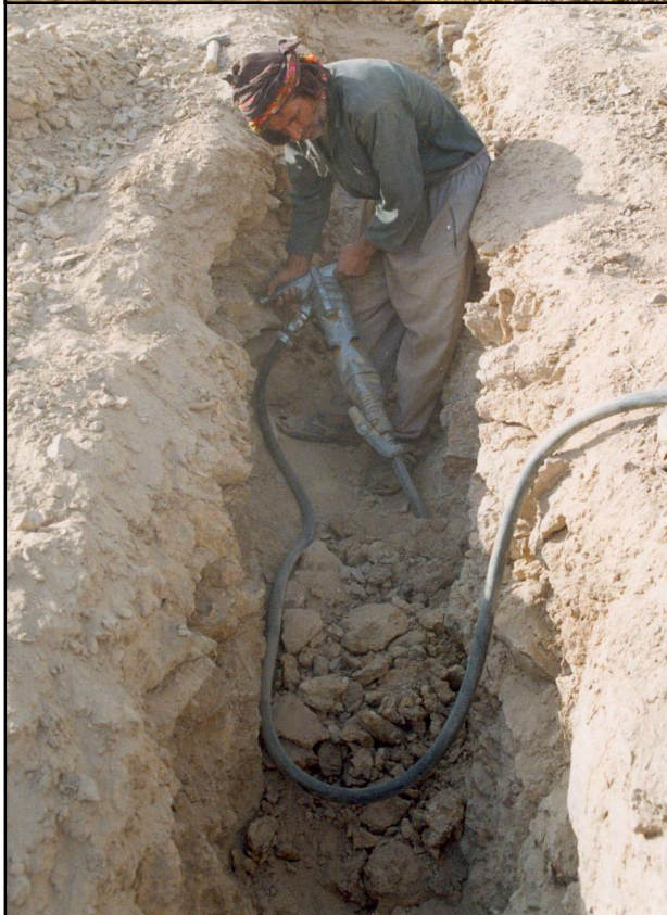
عکس شماره ۳-۱ : حفر ترانشه های اکتشافی در محدوده طلای تارگت شماره (۱)
