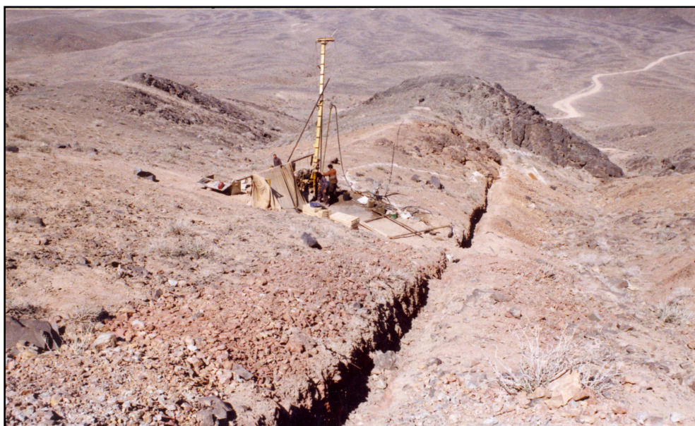
عکس شماره ۳-۱۱ : حفر گمانه اکتشافی شماره ۳ در راستای ترانشه اکتشافی (دید به سمت شمال)
