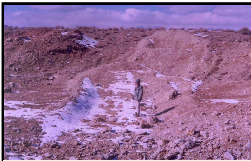
شکل ۳-۷۷- نمایی از ترانشه کارگاه شماره ۲ با امتداد N300E بطول ۳۰ متر و عرض ۳-۵ متر (دید به سمت خاور).
