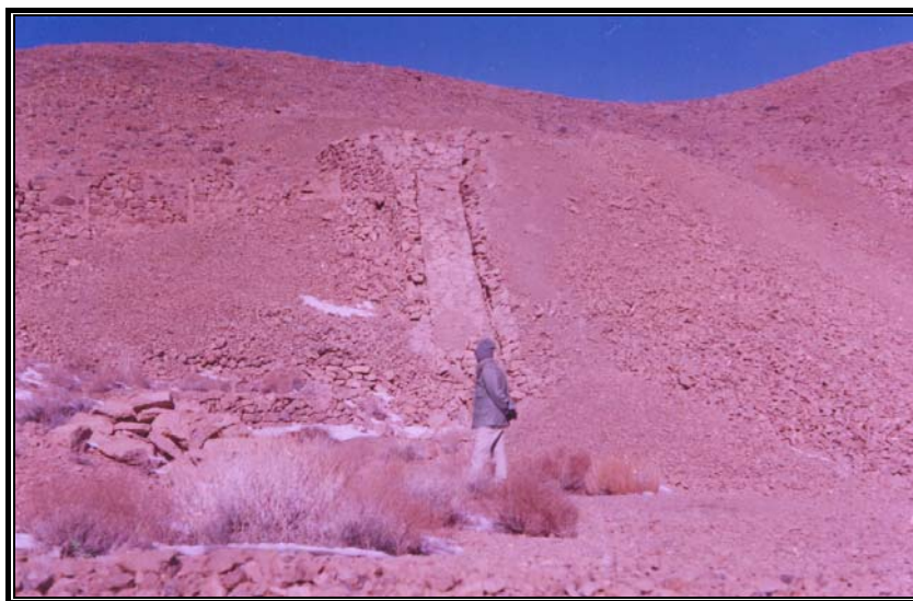
شکل ۳-۷۱- نمائی از ناو سنگی جهت تخلیه مواد معدنی در بخش شمال باختری معدن سرب شخاب (دید بسمت شمال).
