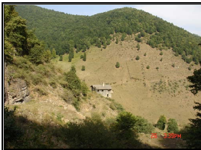
شکل ۳-۱۳- دورنمایی از ساختمان متروکه پناهگاه راشک (دید به سمت شمال).
