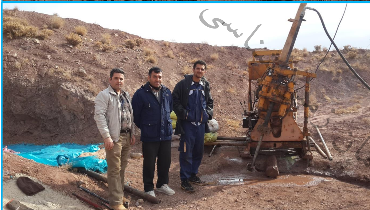
تصویر (۷-۳): نمایی از کارگاه حفاری - گمانه شماره BH۲-۹۶ (دید به خاور)
