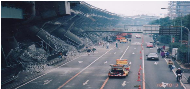
شکل 6 خرابی پل فوکه بزرگراه هانشین در زلزله کوبه به علت تشدید ناشی از نزدیکی به گسل و ایجاد تغییر شکل های بزرگ [10].
