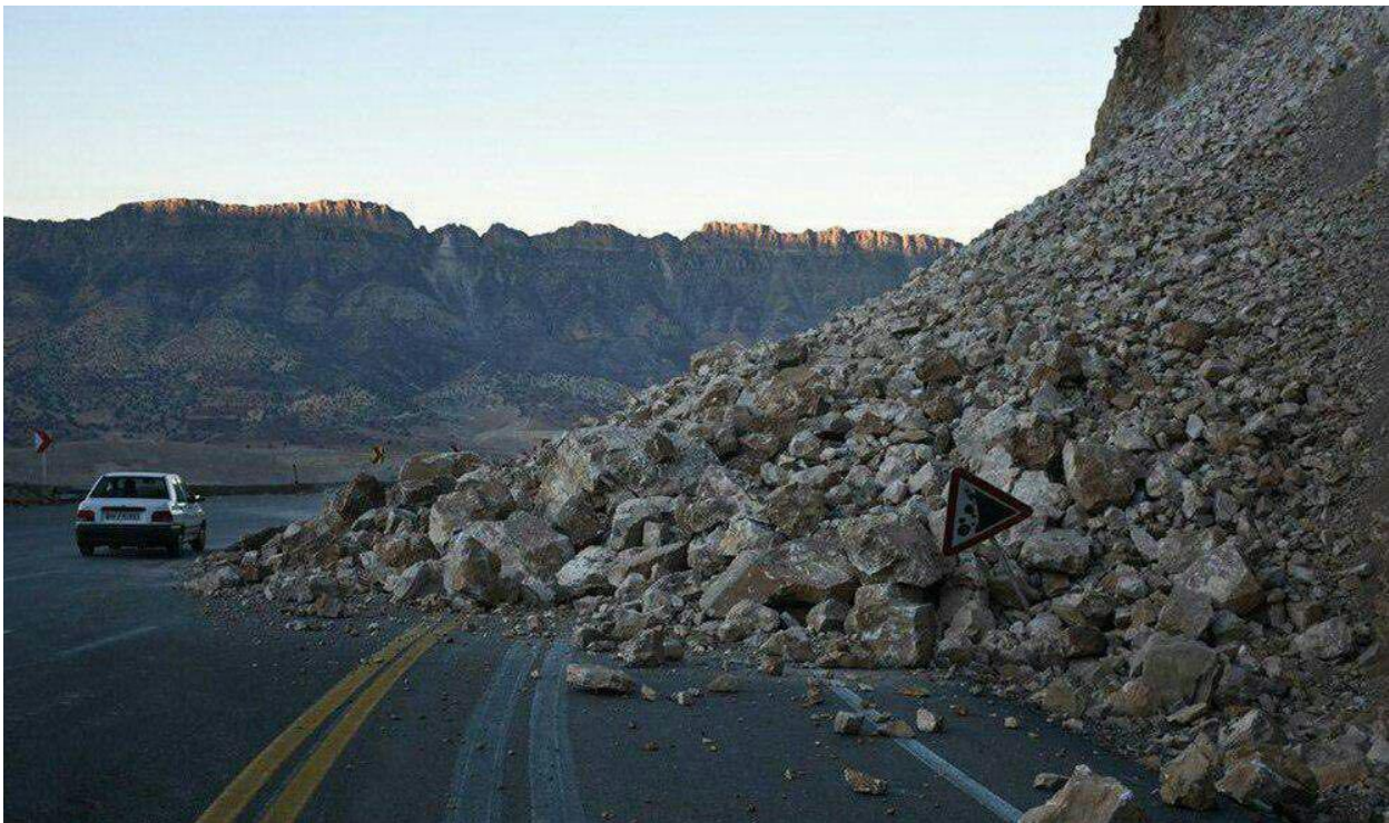
شکل 3 فروریزش سنگ در محور دالاهو اسلام آباد بعد از گردنه پاتاق به طول تقریبی 300 متر (زلزله 1396 ازگله)
