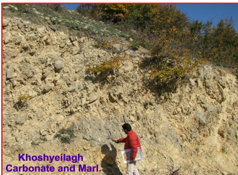
تصویر ۴-۲۱: بخش‌های کربناته و مارنی خوش ییلاق (Khoshyeilagh Carbonate and Marl) در ترازهای توپوگرافی پایین تر که در اثر حفاری‌های ساخت و ساز عمرانی رخنمون یافته است.
