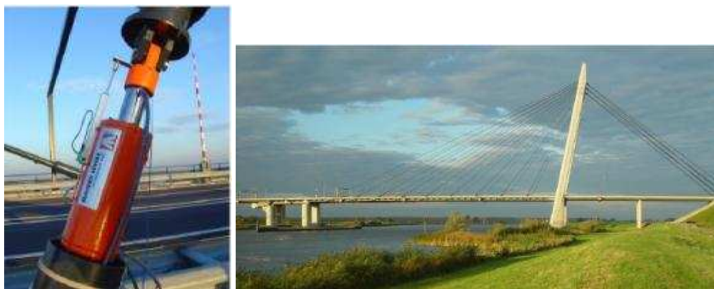
شکل الف-۵۵- پل کابلی Eiland، واقع در هلند، تقویت شده با میراگر MR در سال ۲۰۰۴ میلادی
