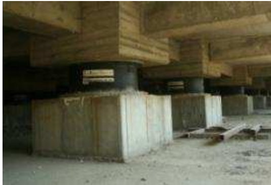
شکل الف-۳- استفاده از جداساز لرزه‌ای در سازه‌های ساختمانی
