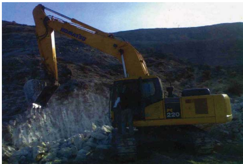
تصویر ۱۶-۳ بیل مکانیکی مورد استفاده جهت حفاری ترانشه ها و سینه کار
