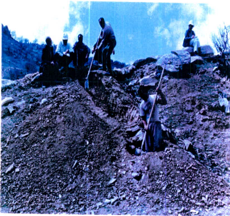
عکس ۳۱ - نمایی از ترائشه ۱، قسمت بالای ترائشه لایه اصلی فسفات و قسمت زیرین ترائشه (برجستگی زیرین) لایه دوم کم‌تیار. در حاشیه سمت چپ عکس آهک مازنی دیسکی شکل دیده می‌شود - نگاه بطرف جنوب شرق.
