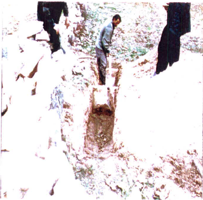
عکس ۳۵ - نمایی از ترانشه ۱۱ - نگاه بطرف جنوب غرب.
