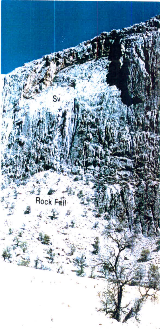
عکس ۲- ساخت فروریختگی گرانشی در سازند سروک و پدیده سنگ ریزش (Rock Fall) در زیر آن - نگاه به سمت شمال شرق.
