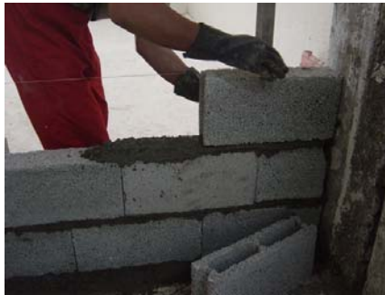
دیوار ساخته شده با بلوک‌های سیمانی حفره‌دار
