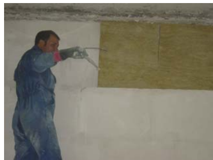
دیوار دوجداره ساخته شده با بلوک‌های گچی با فاصله هوایی پر شده با الیاف معدنی
