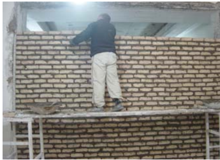
شکل ۴-۱-۱-۱- نمونه‌هایی از آجر فشاری و دیوار ساخته شده با آن در آزمایشگاه
