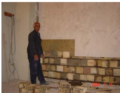
دیوار دوجداره ساخته شده با بلوک‌های سفالی لایه میانی الیاف معدنی
