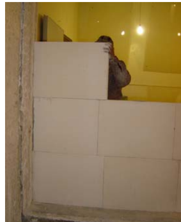
دیوار ساخته شده با بلوک‌های گچی
