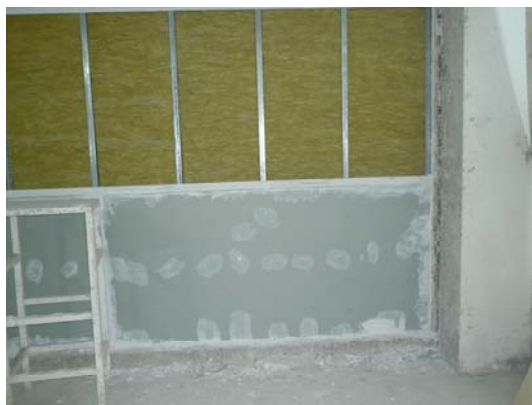
سیستم پوششی با استفاده از الیاف معدنی ۵ سانتیمتری و نصب صفحات گچی
