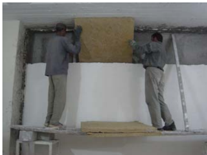
دیوار دوجداره ساخته شده با بلوک‌های سیمانی حفره‌دار با فاصله هوایی پر شده با الیاف معدنی
