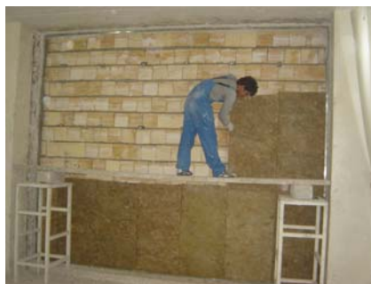
سیستم پوششی با استفاده از الیاف معدنی ۵ سانتیمتری
