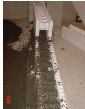
شکل ۴-۵-۳- ساخت دیوار با سیستم ICF با بلوک‌های پلی استایرن انبساطی در آزمایشگاه
