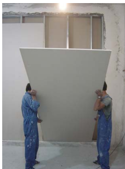
شکل ۴-۴-۴- نمونه‌هایی از دیوارهای ساخته شده با سیستم LSF با فاصله هوایی و نصب صفحات گچی در آزمایشگاه
