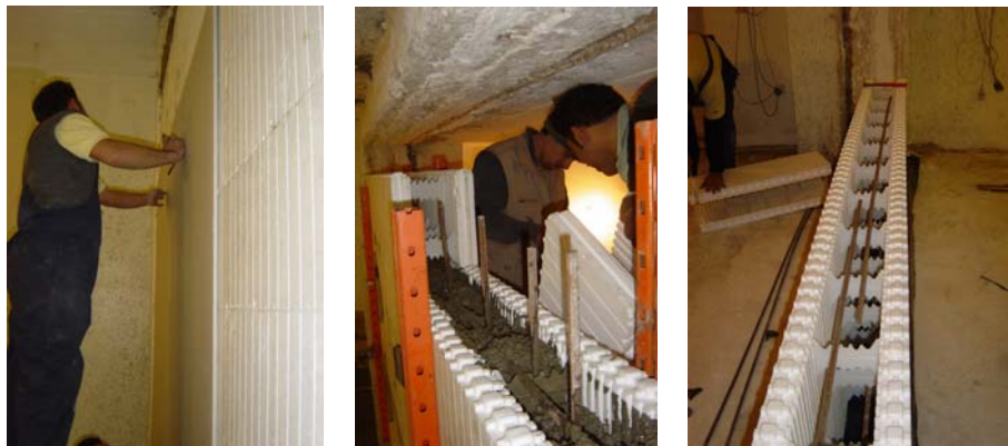
شکل ۴-۵-۲- ساخت دیوار با سیستم ICF با اتصالات پلاستیکی در آزمایشگاه
