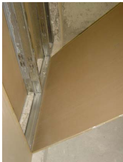
شکل ۴-۴-۴- نمونه‌هایی از دیوارهای ساخته شده با سیستم LSF با فاصله هوایی و نصب صفحات گچی در آزمایشگاه
