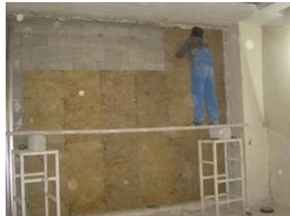
سیستم پوششی با استفاده از الیاف معدنی ۵ سانتیمتری و نصب صفحات گچی
