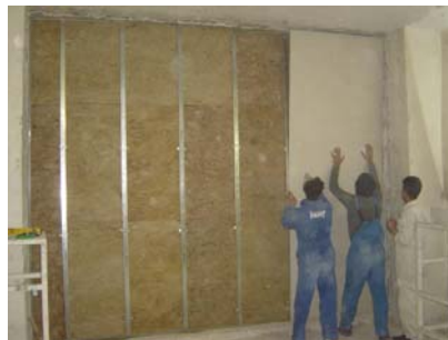
سیستم پوششی با استفاده از الیاف معدنی ۵ سانتیمتری و نصب صفحات گچی
