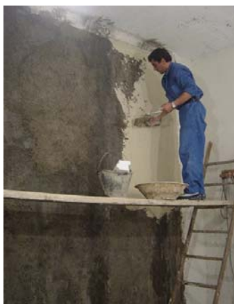
ادامه شکل ۴-۶-۲- ساخت دیوار با سیستم 3D در آزمایشگاه
