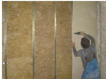
سیستم پوششی با استفاده از الیاف معدنی ۵ سانتیمتری
