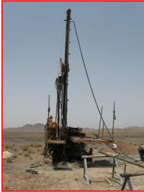
نگاره ۳-۶۴: حفر گمانه در دشت آبرفت ماهرآباد
