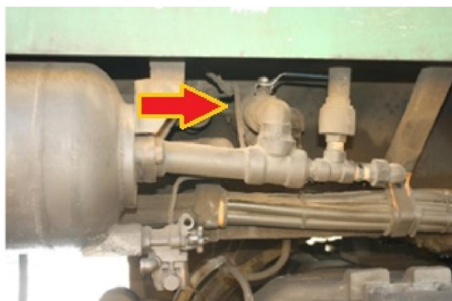
شکل ۳-۲۶) شیر کنارگذر خشک کن لکوموتیو GM که در کنار سوپاپ اطمینان ۱۶۰ psi نصب شده است.
