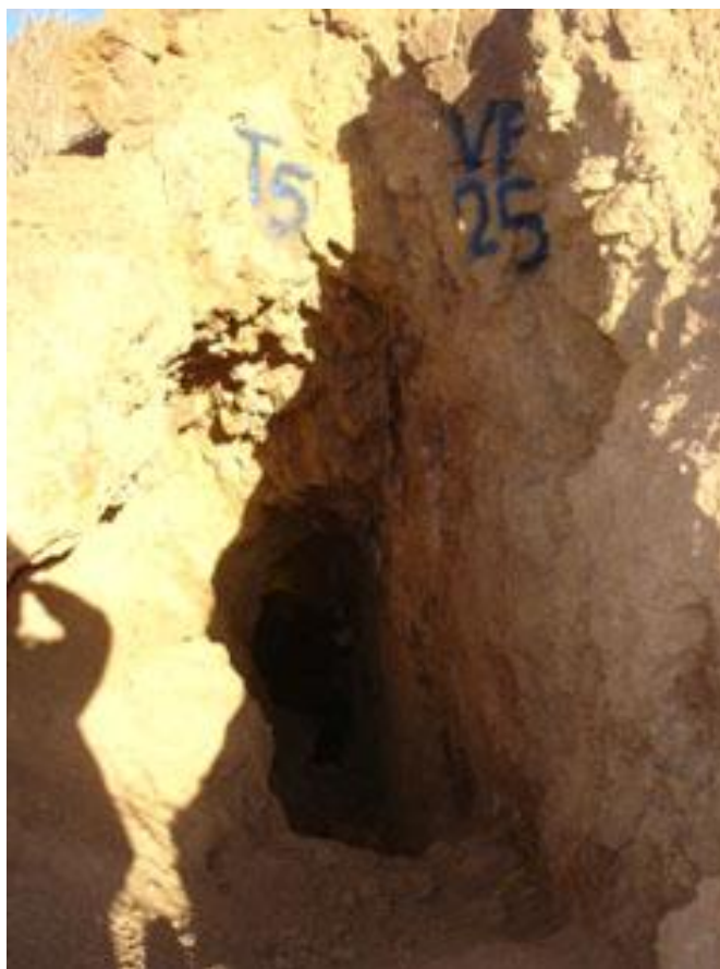
عكس شماره 73-3 نمايي از تونل T5 و گسلي كه در امتداد آن حفر شده است. (ديد بسمت جنوب غرب)
