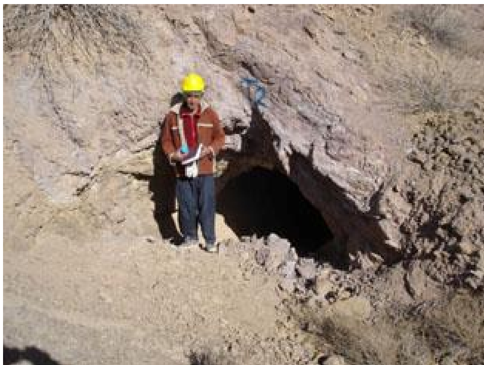
عکسهای شماره 69_3: نمایی از تونل T2 که در حاشیه گسل حفر شده است. (دید بسمت جنوب غرب)
