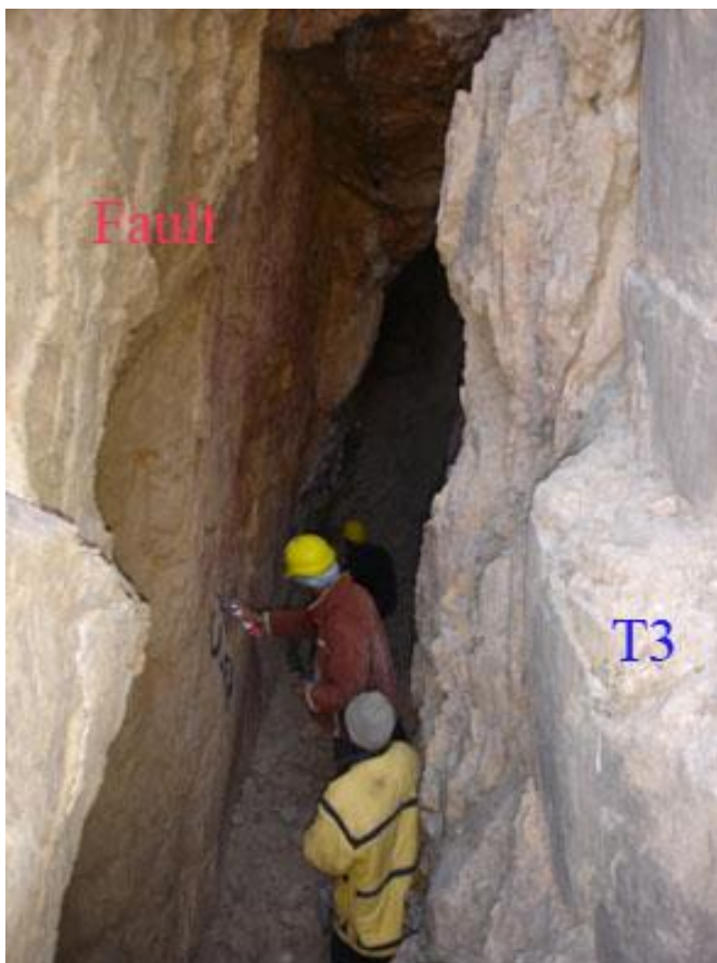
عکس شماره 79_3: نمایی از داخل تونل T3. (دید بسمت شمال غرب)
