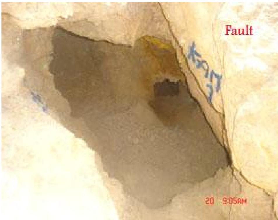
عکس شماره 168_3: نمایی از تونل T1 و گسلی که در امتداد آن کنده کاری شده است. دید به سمت شمال شرق.
