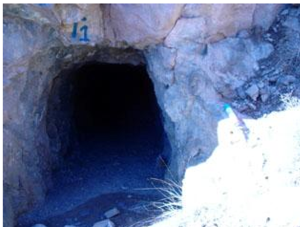
عکس شماره 3-125: نمایی از دهانه ورودی تونل T1 (دید به سمت جنوب غرب)
