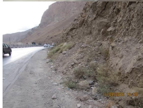
شکل ۱۷. وجود پدیده‌های ریزش، لغزش و رواناب در نقطه
