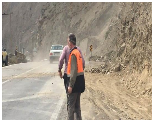
شکل ۱۳. رخداد ریزش حین بازدیدهای میدانی مسیر جاده هراز-
