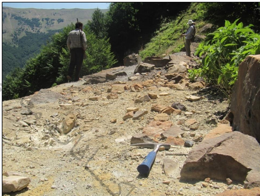
شکل ۲-۱۴- ریزش دهانه تونل، دید به سمت جنوب خاور
