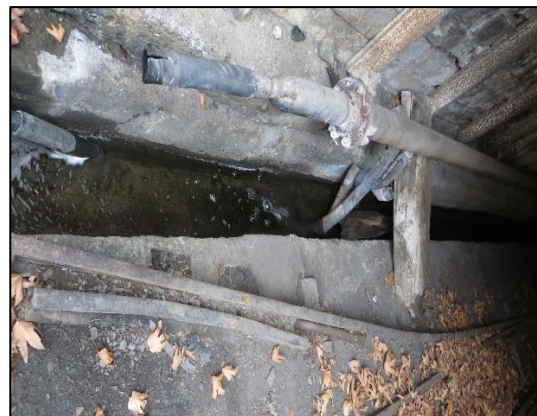
شکل ۳-۲- نمایی از تونل شماره ۹ و سیستم نگهداری قاب فلزی (آرک) و سیستم آبکشی
