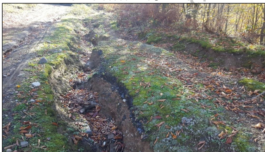
شکل ۱۰-۲- جاده تخریب شده در مسیر معدن
