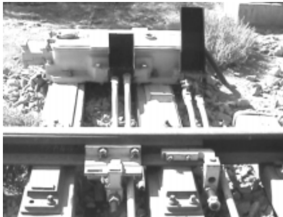
شکل ۵-۲۶ ماشین سوزن ژاپنی
