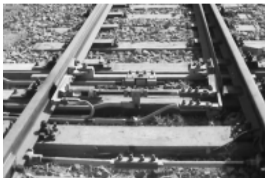
شکل ۴-۹ عایق بندی میله تنظیم عرض خط و فاصله دو ریل
