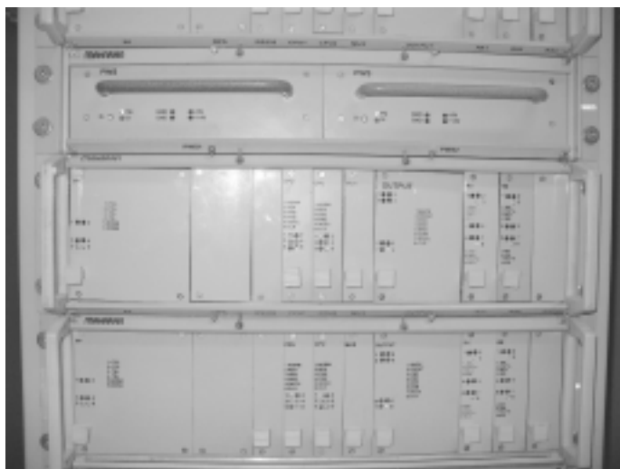
شکل ۴-۲۵ راک مدار خط فرکانسی
