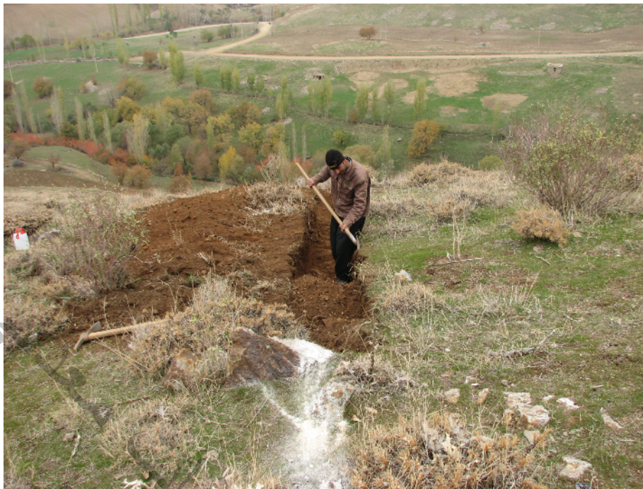
تصویر ۳: عملیات حفر ترانشه در محدوده اکتشافی قبعلوجه جنوبی
