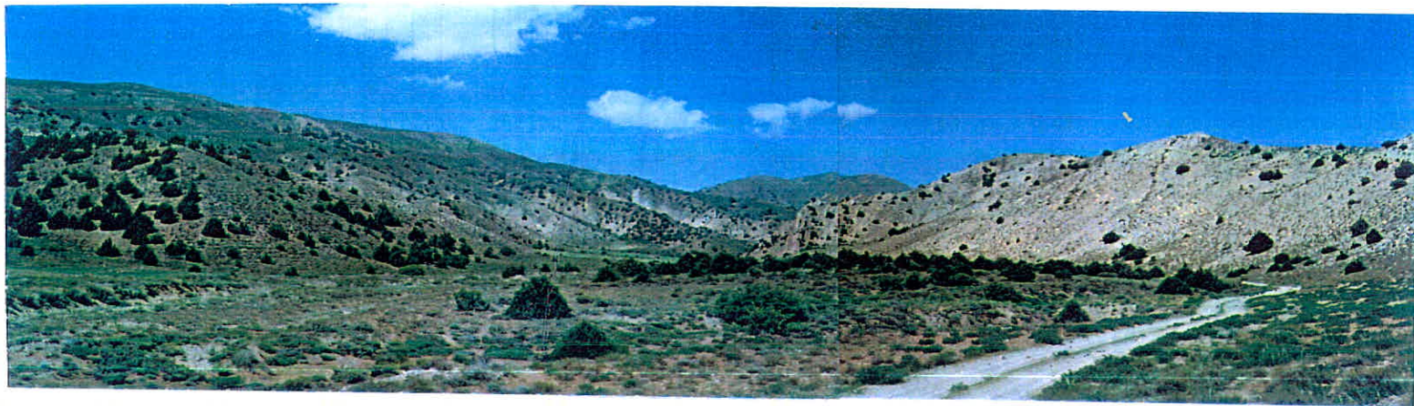
عکس شماره (۲-۴) - شمای کلی رشته کوه شاهکوه ( برفکه کهکشان )، پوشش گیاهی و شبکه آبراهه ای منطقه. دید به سمت جنوب شرق
