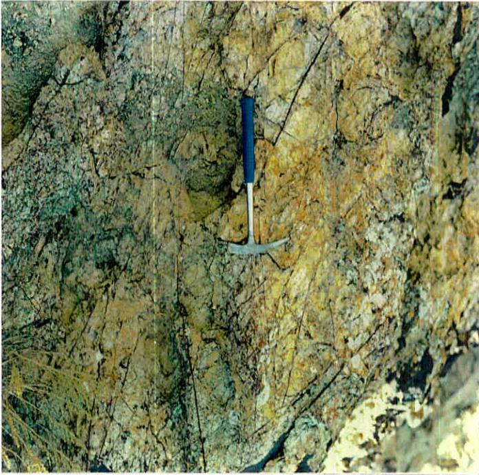
نمونه شماره ۱ - خرد شدگی شدید واحد Erdt و رشد درزه‌های شکستگی
