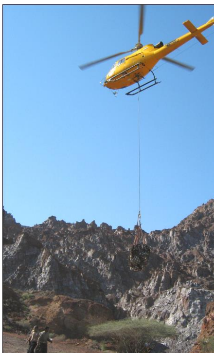
شکل 3-7 - انتقال دستگاه حفاری و سایر تجهیزات به ارتفاع 300 متری کوه نمک پل.
