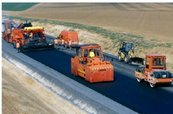
شکل ۲-۱۸) اجراء و تراکم لایه آسفالتی
