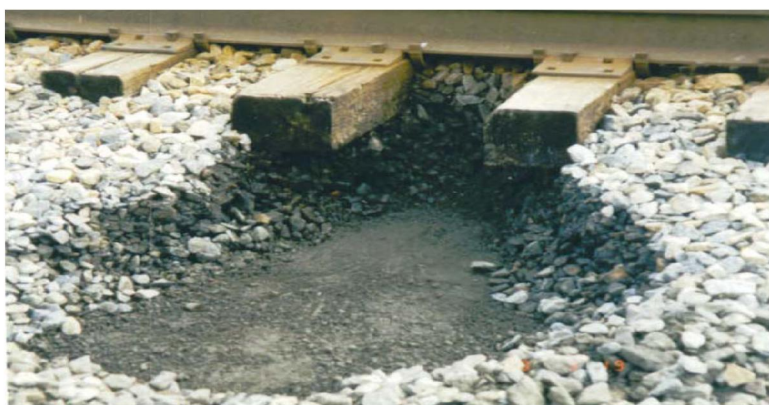
شکل ۵-۳) HMA زیرلایه در زیرسازی خط با بالاست و تراورس چوبی
