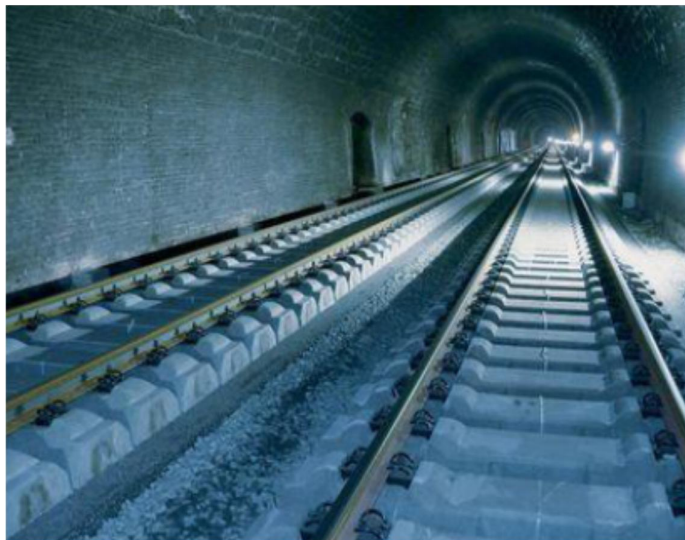
شکل ۲-۱۷) نمایی از ساختار نهایی خط گترک پس از تکمیل مراحل احداث ۱
