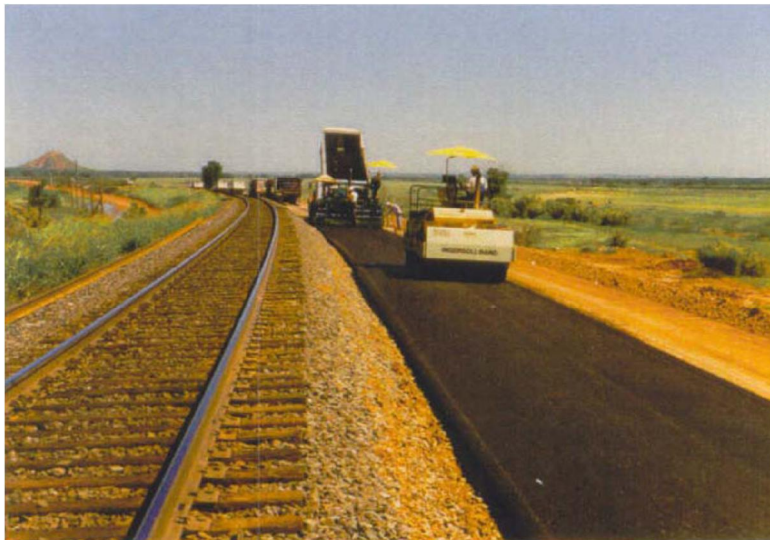
شکل ۵-۲) اجرای یک زیرلایه از HMA روی بستر در پروسه ساخت خط دوم
