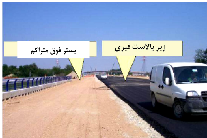
شکل ۲-۹) بستر فوق متراکم در کنار لایه آسفالتی
