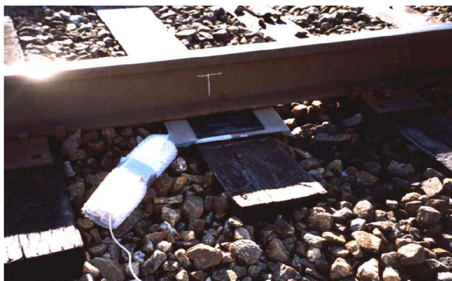
شکل ۶-۵) نمایی از داخل خط تست
