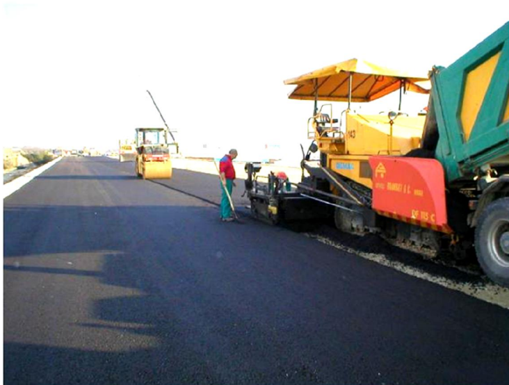
شکل ۲-۱) پخش لایه آسفالت توسط ماشین‌های استاندارد پخش آسفالت و تراکم آن
