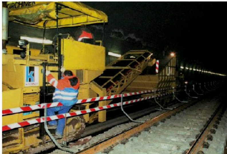
شکل ۲-۱۵) پخش پوشش آسفالتی در تونل
