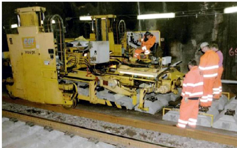
شکل ۲-۱۶) نصب تراورس‌های بتنی
