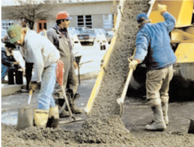
شکل ۸-۱۲ اغلب بتن آماده را می‌توان در موقعیت نهایی بوسیله تخلیه مستقیم توسط شوت از کامیون مخلوط‌کن ریخت
