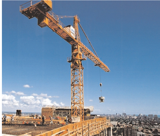
شکل ۸-۱۴ تاورکرین و جام می‌تواند بتن را به سادگی برای ساختمان‌سازی آسمانخراش‌ها فراهم کند
