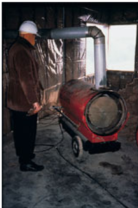
شکل ۱۳-۱ آب کردن یخ سنگدانه‌ها با دستگاه گازسوز تولیدکننده هوای گرم در زیر پوشش برزنت
