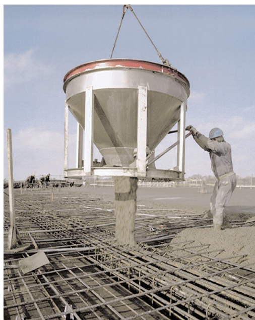
شکل ۸-۱۱ بتن به راحتی به موقعیت نهایی توسط جام و جراثقال منتقل می‌شود
