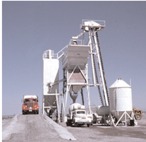
شکل ۸-۶ بتن آماده توسط کامیون بتن ساز (مخلوط‌کن)
