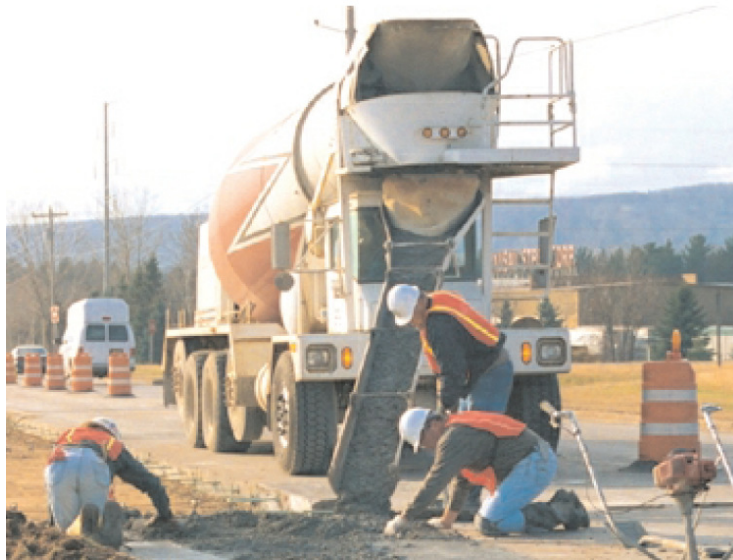
شکل ۸-۱۳ در مقایسه با کامیون‌های تخلیه از انتهای مرسوم، کامیون‌های مخلوط‌کن تخلیه از جلو برای راننده، امکان کنترل و تحرکت بیشتری در بتن‌ریزی فراهم می‌آورد
