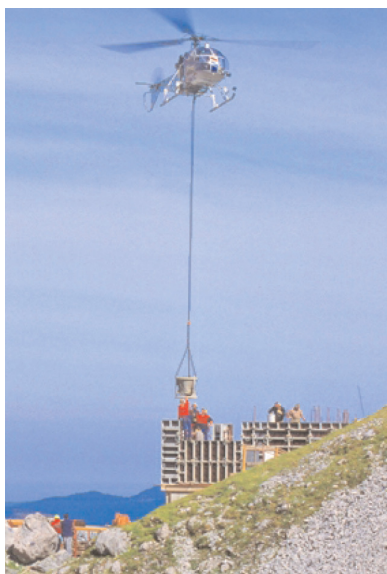
شکل ۸-۱۹ برای کار در بالای سطح زمین یا در کارگاه‌های غیر قابل دسترس، جام بتن را می‌توان توسط هلیکوپتر بالا برده و برای بتن‌ریزی استفاده نمود
