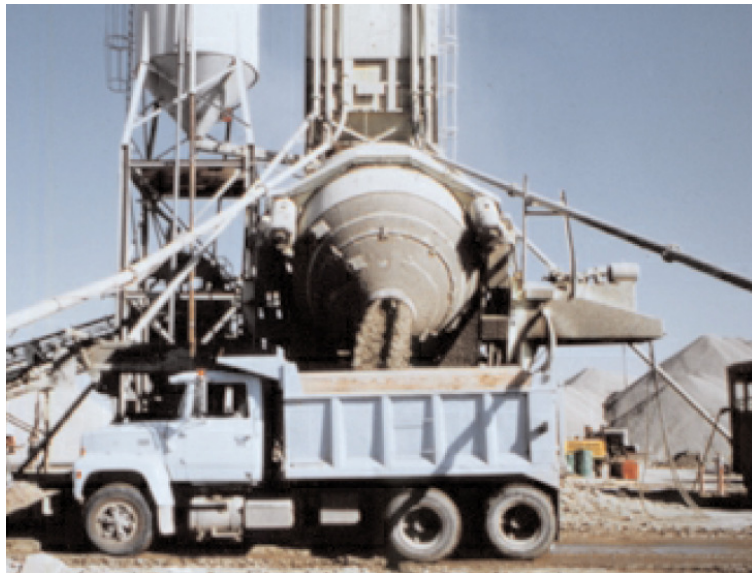
شکل ۸-۲ بتن می‌تواند در یک واحد مخلوط‌کن مرکزی در محل کارگاه ساختمانی تولید شود
