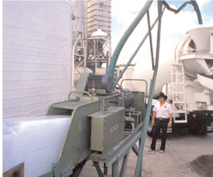
شکل ۱۴-۳ جایگزینی بخشی از آب اختلاط با یخ جهت کاهش دمای بتن
