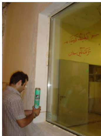
تزریق فوم در پیرامون شیشه برای درزبندی
