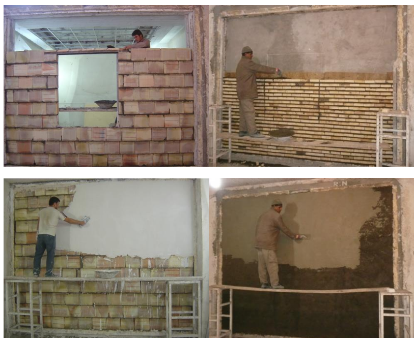
شکل ۲-۳۴ مراحل ساخت دیوار دوجداره بین دو اتاق منبع و دریافت
