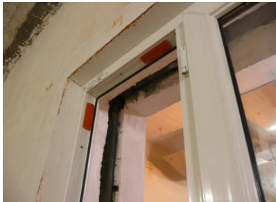
استفاده از فیلر برای رگلاژ پنجره
