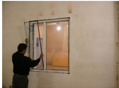
جاگذاری شیشه‌ها درون قاب پنجره
