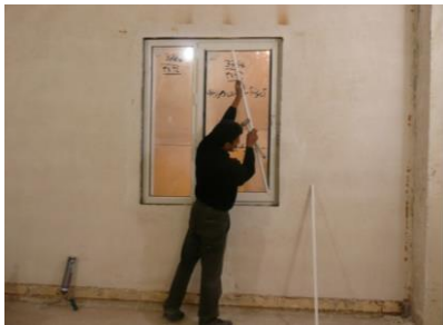
تکمیل مراحل نصب
