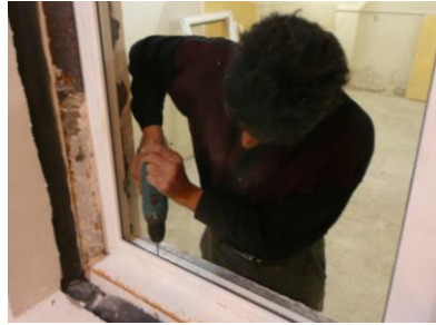
پیچ کردن قاب پنجره به دیوار
