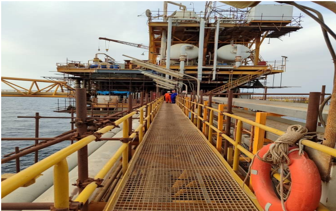
شکل ۲- بالا بودن درصد خوردگی تأسیسات نصب شده در سکوی استخراج نفت فروزان به دلیل عمر بالای تأسیسات
